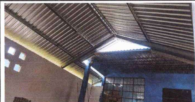
Foto 3: Instalación de estructura de techo y repello de pared.
