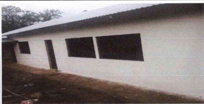
Foto1: Se observa el trabajo del entechado, repellido de paredes interior y exteriores, colocación de ventana y puertas en el modulo 1
