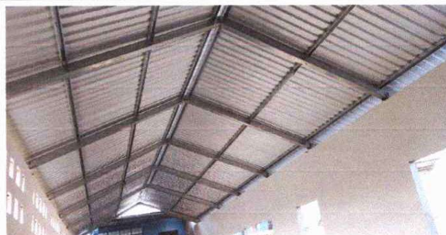
Foto 2: La instalación de estructura de techo e instalación de lámina.
