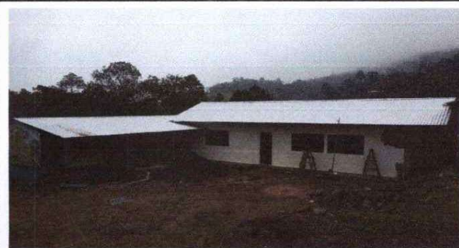
Foto 4: Se observa la instalación de la estructura de techo en los modulo No. 1 y 2. y repello de pared interior y exterior.
